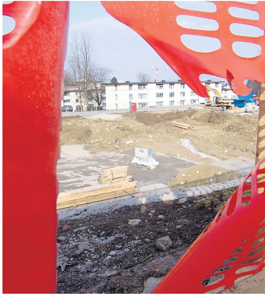
An der Schönheimstrasse wird eine ganze Siedlung abgerissen und neu aufgebaut.
